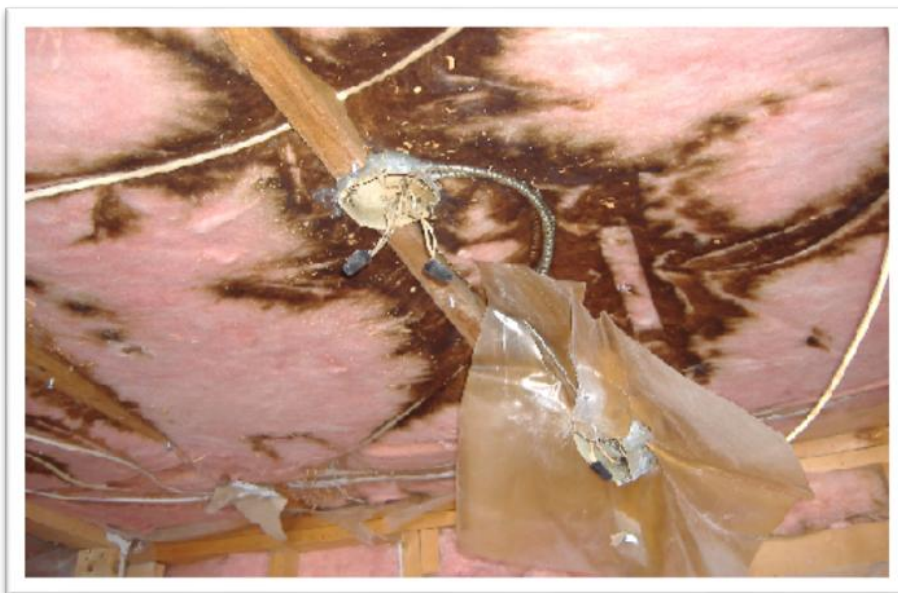
Dommages causés par la fumée tertiaire au plafond d'une habitation après 10 ans de tabagisme intense. Photo gracieuseté de la HCHC.
